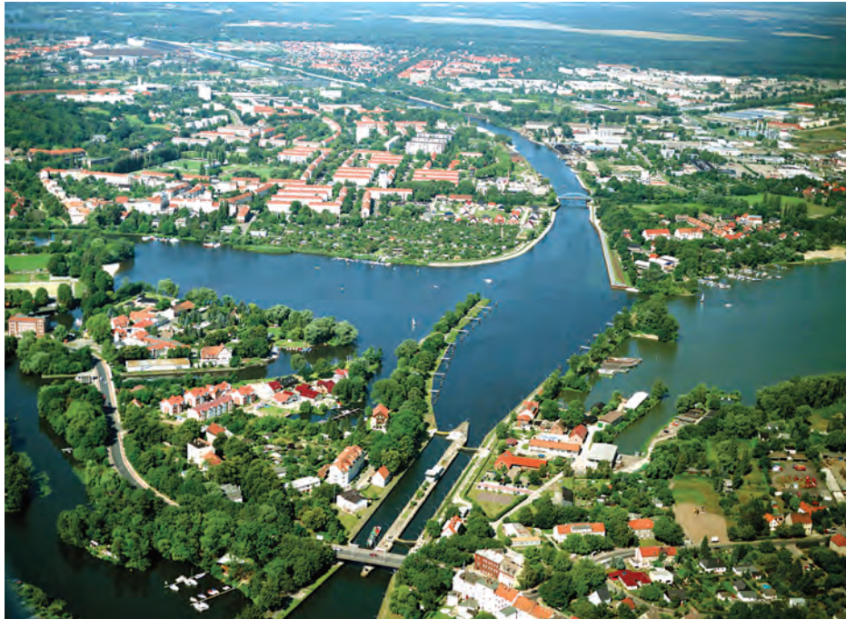
Blick über die Vorstadtschleuse Brandenburg in Richtung Westen
