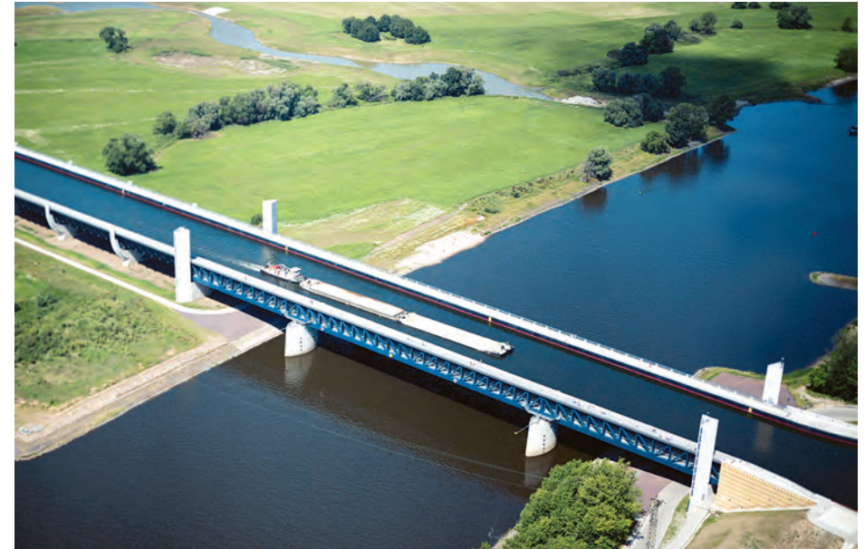
Wasserstraßenkreuz Magdeburg, Kanalbrücke
