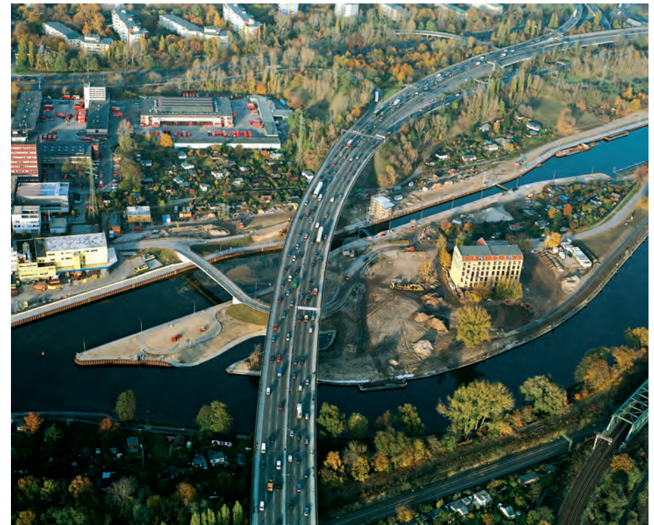
Blick auf die neue Schleuse Charlottenburg
