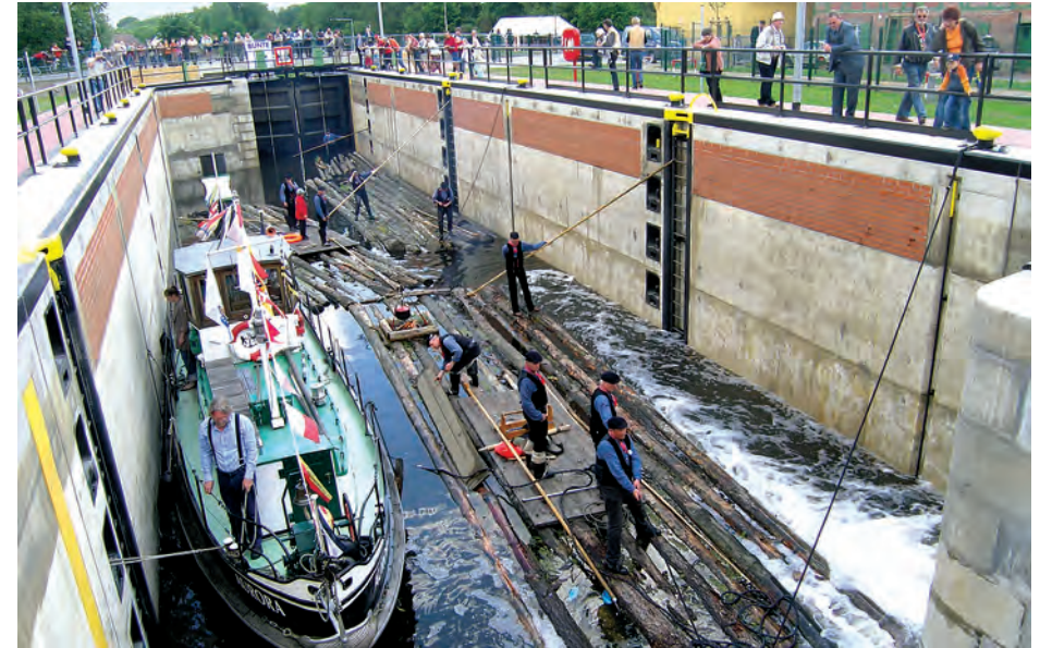
Die grundinstandgesetzte und teilneugebaute Schleuse Schöpfung, Finowfurt: Erste Schleusung zu Berg nach der Verkehrsfreigabe im Mai 2007
