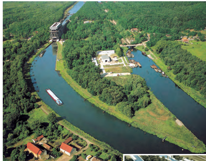
Blick auf das Schiffshebewerk Niederfinow mit unterem Vorhafen
