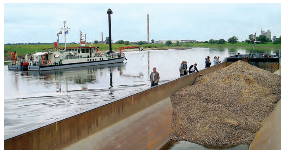
Der ungewollten Eintiefung der Flusssohle wird mit der Zugabe von Geschiebematerial begegnet.
