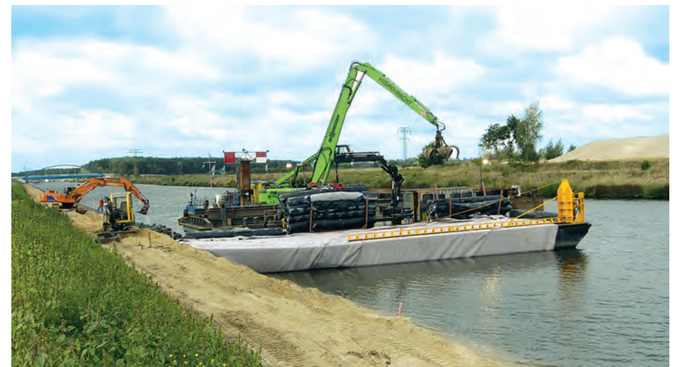
Baustelle am Elbe-Havel-Kanal
